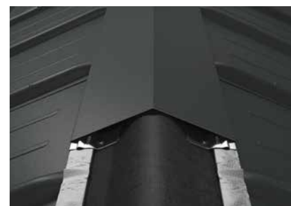
Figura 73 • Raccordo del colmo con semplice calotta copricolmo
