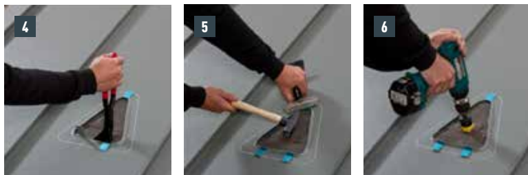
Figura 70 • Posa della bocchetta Solar
