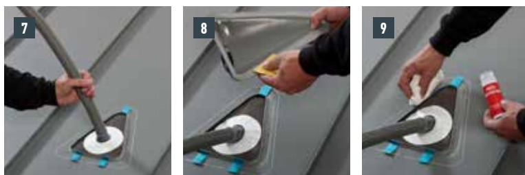
Figura 71 • Posa della bocchetta Solar
