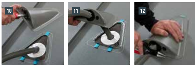
Figura 72 • Posa della bocchetta Solar
