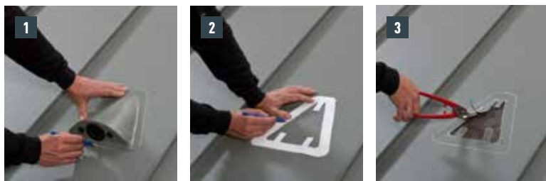
Figura 69 • Posa della bocchetta Solar
