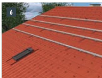
Figura 64 • Sistema a montaggio ultimato (posa semplice)
