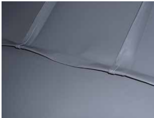
Figura 39 • Posizione dell'aggraffatura in caso di penetrazione
