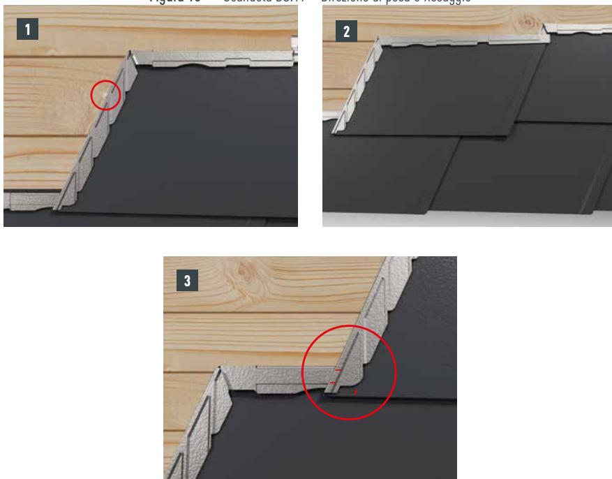
Figura 16 • Scandola DS.19 – Direzione di posa e fissaggio
