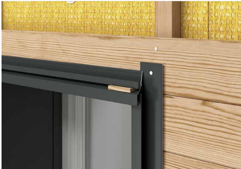
Figura 83 • Montaggio del profilo ripiegato dell'architrave della finestra
