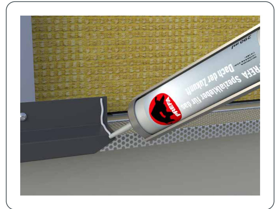
Figure 68 • Joint du renvoi d'eau
