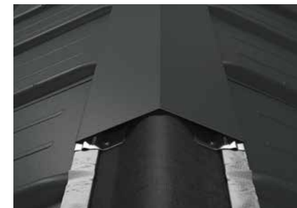
Figure 73 • Réalisation d'un faîtage avec faîtière simple
