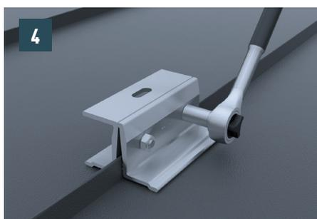
4 Visser les deux écrous en acier inoxydable avec un couple de serrage de 35 Nm.
