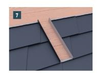
Si la couverture de toit est réalisée avec des éléments PREFA petit format, il peut s'avérer nécessaire de poser une plaque de support afin de pouvoir monter le support solaire Vario ou Fix — par exemple lorsqu'un emboîtement se trouve juste au-dessus du chevron, à l'endroit où le support solaire doit être posé.
