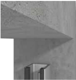
32 Afin de pouvoir insérer le batardeau supérieur dans les profils, découper la partie supérieure du montant latéral de chaque profil.
