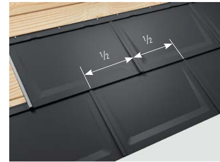
Abbildung 50 • Dachplatte R.16 – Verlegung und Deckrichtung
