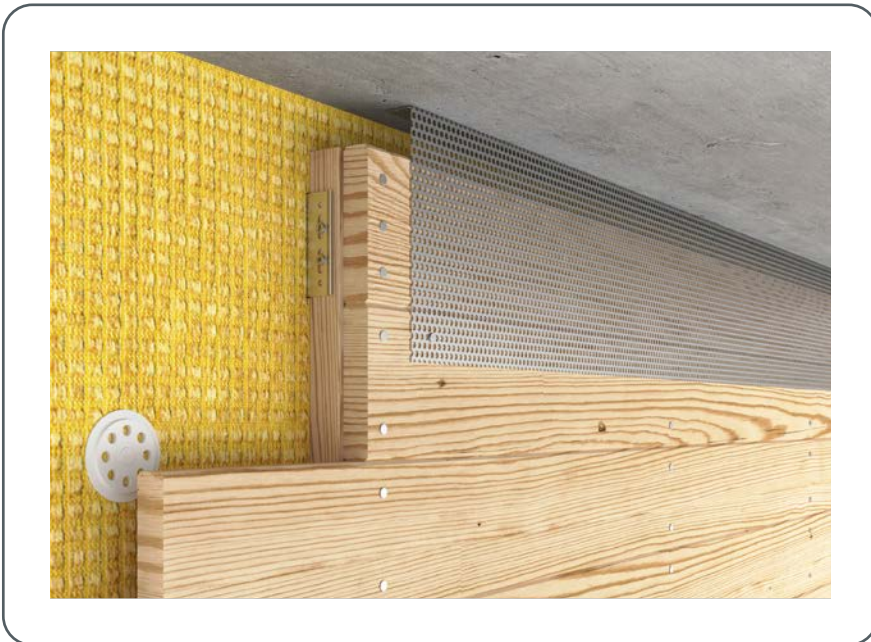
Abbildung 72 • Oberer Anschluss – Vorbereitung
