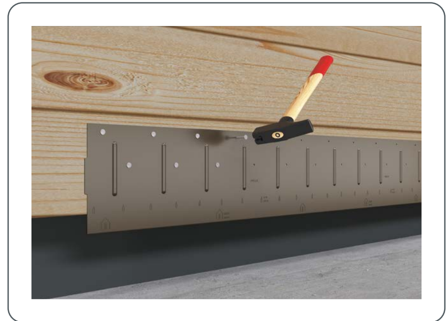
Abbildung 59 • Saumstreifen – Befestigung
