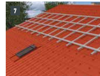
Abbildung 71 • Fertig montiertes Montagesystem (im Kreuzverbund bei höheren Belastungen)
