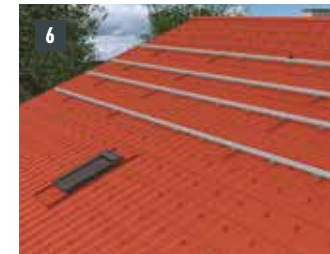
Abbildung 70 • Fertig montiertes Montagesystem (einlagig)
