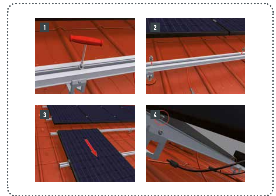
Abbildung 54 • Modulabsturzsicherung
