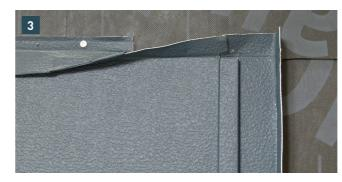
Oberen Falz der PREFA Dacheindeckung öffnen und die Dacheindeckung seitlich an der Markierung aufstellen. [3]
