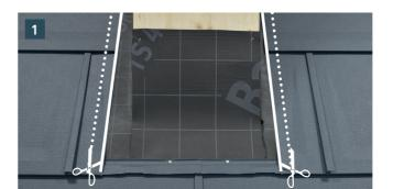
Beim Anschluss an den Kamin 30 mm Überstand für den Stehfalz anzeichnen und die PREFA Dacheindeckung beschneiden. [1]
