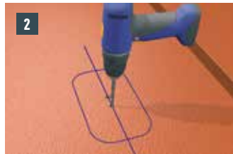
2 Langloch (Ø 13 mm) in der Prefalz-Bahn vorbohren (Bohrung ausreichend bei Kleinformat).
