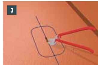
3 Langloch in der Prefalz-Bahn ausschneiden (entfällt bei Kleinformat).
