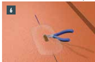
6 Langloch oder Bohrung aufbördeln.
