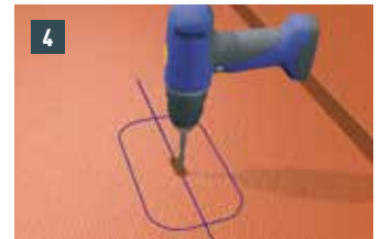
4 Die Unterkonstruktion mittig im Langloch oder in der Bohrung mit Ø 8 mm vorbohren.
