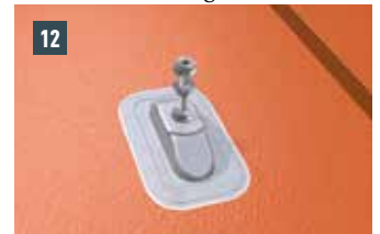
12 Flanschmutter zum Befestigen des Solarprofils aufschrauben.
