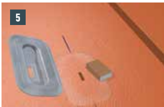
5 Klebestelle an der Dacheindeckung und am Solarhalter Sunny anschleifen.
