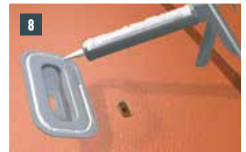
8 Kleberraupe (Ø 10 mm) auf den angeschliffenen und gereinigten Solarhalter auftragen.
