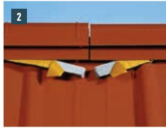
**2** Dehnfugen von ca. 5 mm zwischen den einzelnen Firstentlüftern einhalten und anschließend die Kleberschutzfolie des Dichtkeils ca. 50 mm abziehen und nach außen biegen.
