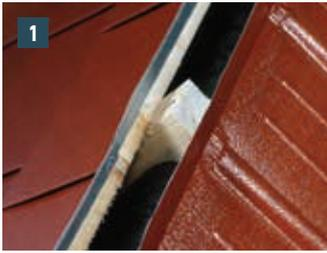
**1** Die Ausrichtung der letzten Reihe soll so erfolgen, dass ein Luftspalt von 80 mm entsteht. Die PREFA Dachelemente ca. 40 mm senkrecht aufstellen.
