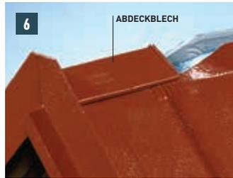
**6** Vorschlag zur Montage des Firstentlüftervorkopfes: Zuerst im Randbereich das Abdeckblech montieren und 30 mm für Giebelstreifen aufstellen. Anschließend Giebelstreifen ansetzen.
