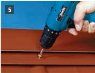
**5** Firstentlüfter mit PREFA Dichtschauben (Länge: 60 mm) im Abstand von ca. 600 mm befestigen. Anmerkung: Bei PREFA Dachplatten die Dichtschaube immer auf den Rillenberg setzen. Bei Dachschindeln und Dachrauten nicht bei schrägem Einhängfalz schrauben. Bei Dachplatten R.16 und Dachpaneel FX.12 nicht am senkrechten Winkel falz schrauben.
