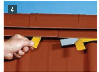
**4** Den Dichtkeil mit der bereits abgezogenen Dichtfläche unter die Verbindungsmanchetten kleben. Anschließend die Kleberschutzfolie vorsichtig abziehen.
