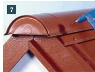
**7** Den Firstentlüftervorkopf anpassen und mit einer Niete befestigen.
