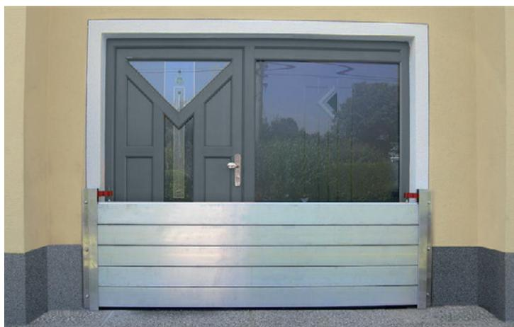
Protezione del portone di un ingresso, con montanti di fissaggio installati davanti alla muratura.
