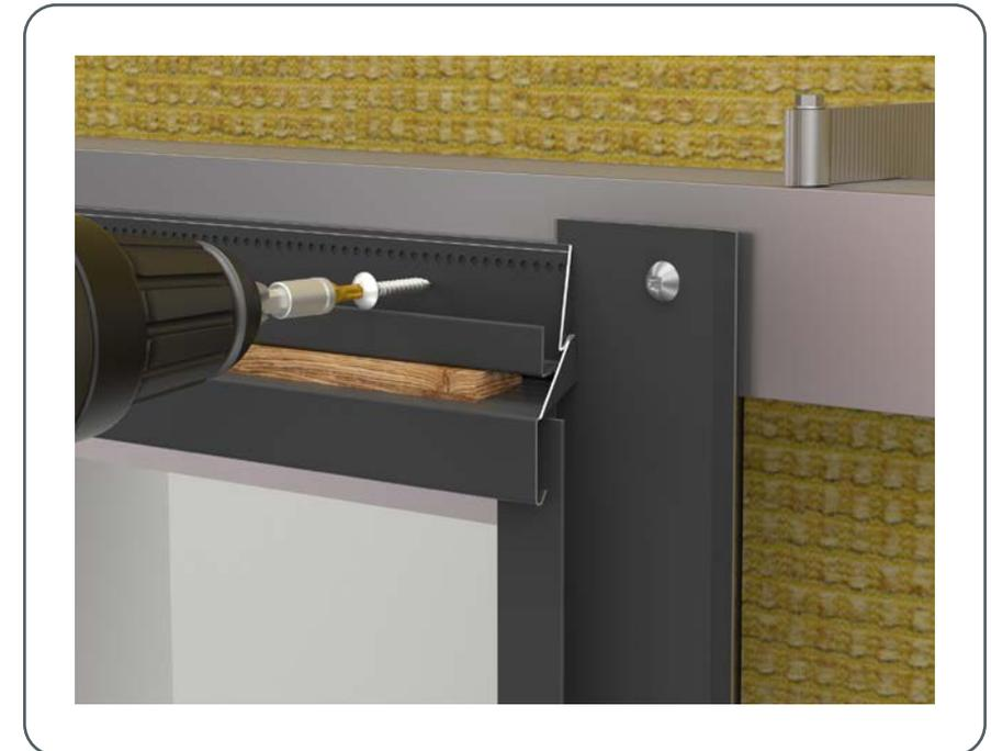
Abbildung 102 • Montage Schnittlochblende Fenstersturz
