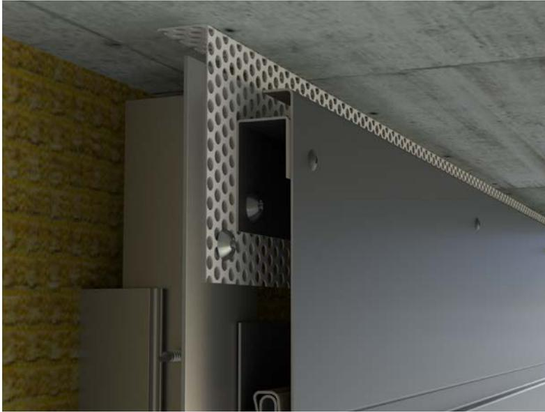
Abbildung 87 • Oberer Abschluss Siding horizontal
