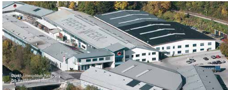
Objekt: Firmengebäude Wasungen Ort: Wasungen (Deutschland)
